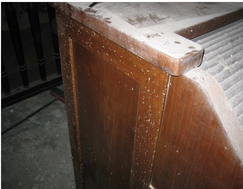
013 Fianco del mobile della consolle pesantemente intaccato dal tarlo
