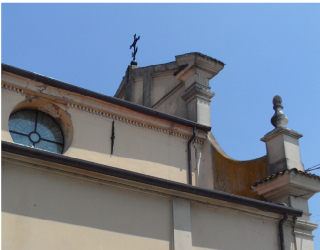
Frontone e timpano dopo la scossa del 20 maggio 2012 (con evidente lesione ribaltamento facciata)
