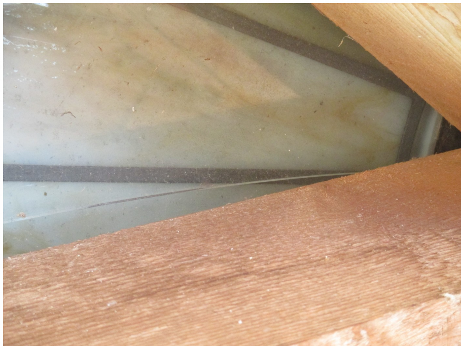
Rosone vista esterna – particolare frattura del controvetro esterno
